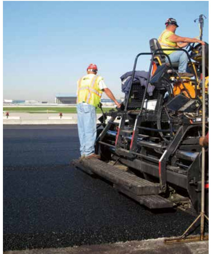
Бригада компании R-Five Construction в первый день укладки покрытия с применением Rediset® LQ в аэропорте О'Хара
